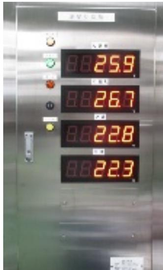
図1 温度計測盤外観
